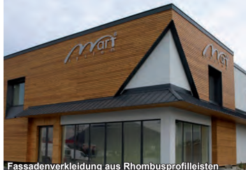
Fassadenverkleidung aus Rhombusprofileleisten
