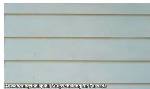
Anwendungsbeispiel: Stülp-schalung für Fassade
